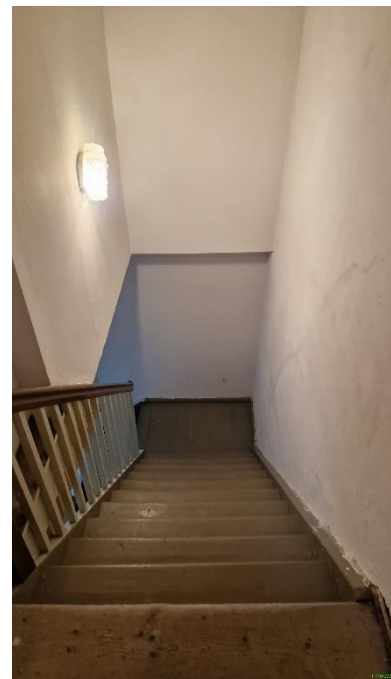
Treppe zum Bodenraum
