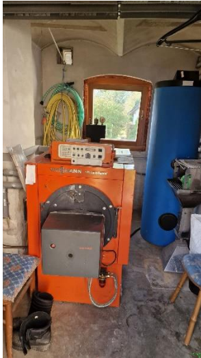
Heizungsanlage
