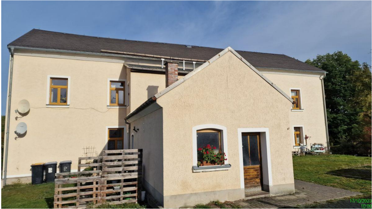
Gebäuderückansicht mit Anbau
