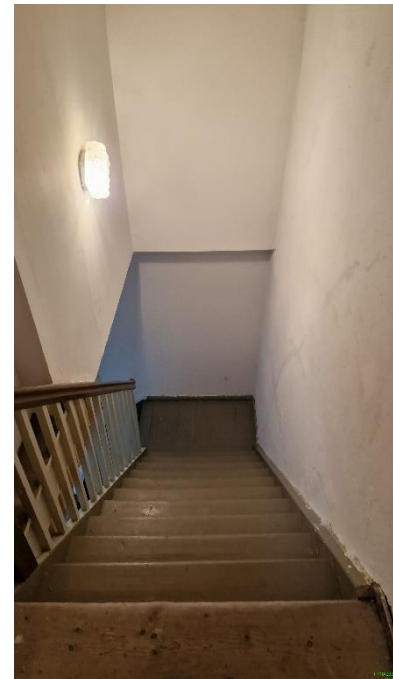
Treppe zum Bodenraum
