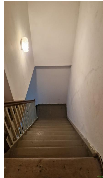
Treppe zum Bodenraum
